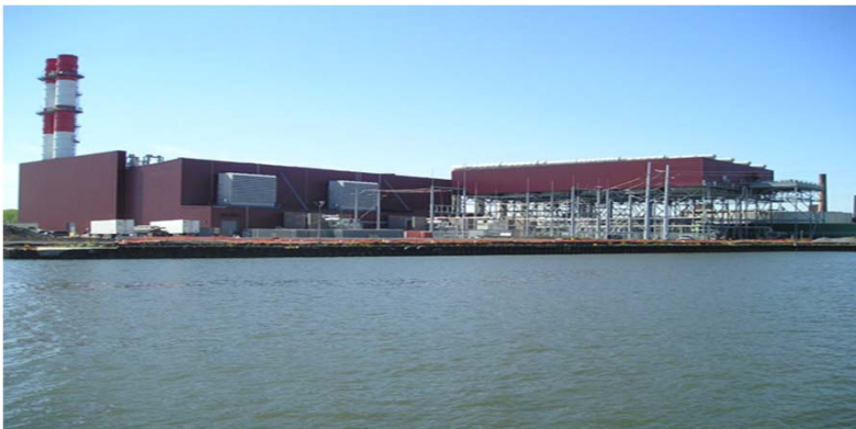
アストリア I ガス火力発電所
