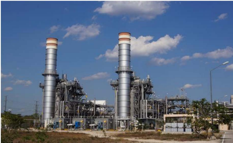
バジャドリ第3ガス火力発電所(メキシコ)
